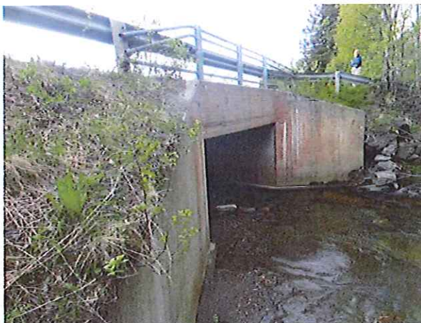
Figur 6 Fv. 858 over Leirbogelva, sett fra nord
