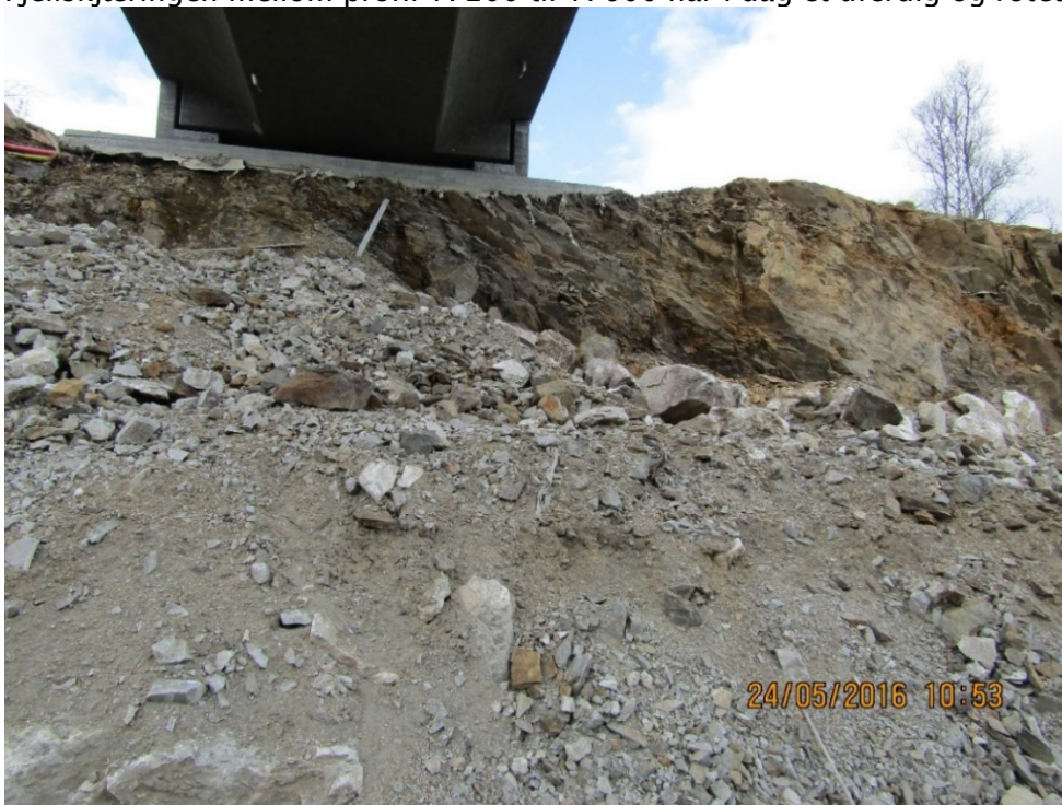
Figur 26 viser fjellskjæringa under forsvarets bruanlegg. Foto: Lars Greger Bakken, Statens vegvesen
