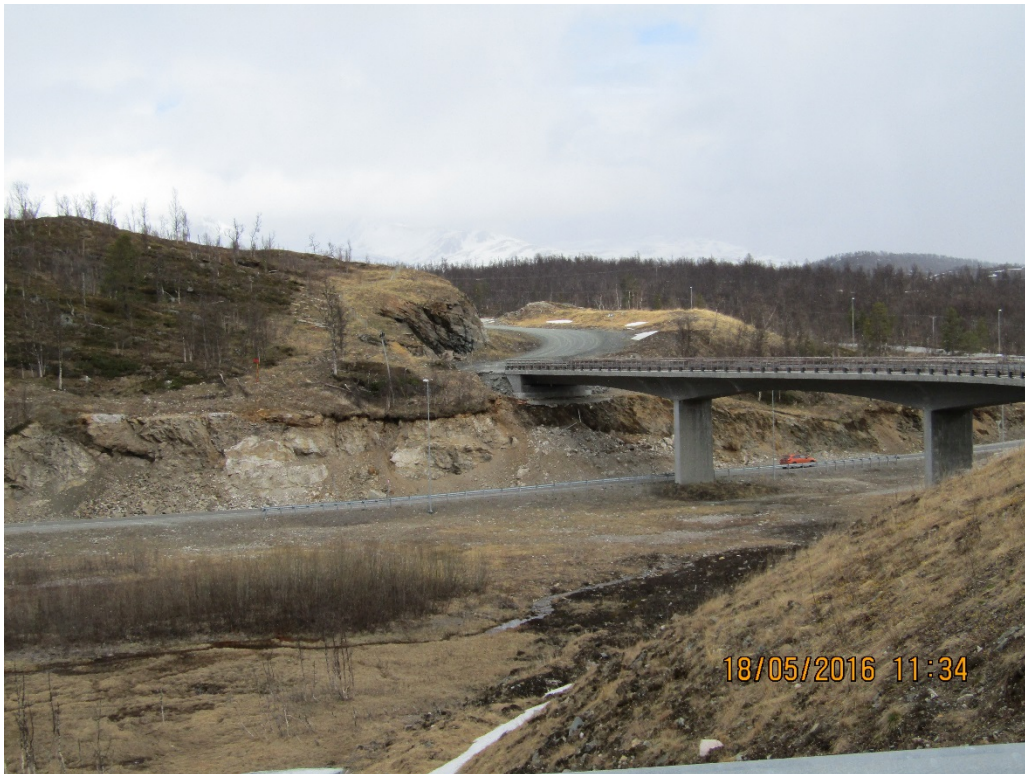
Figur 27 viser bergskjæringer i området der forvarets veganlegg krysser E6. Foto: Lars Greger Bakken
