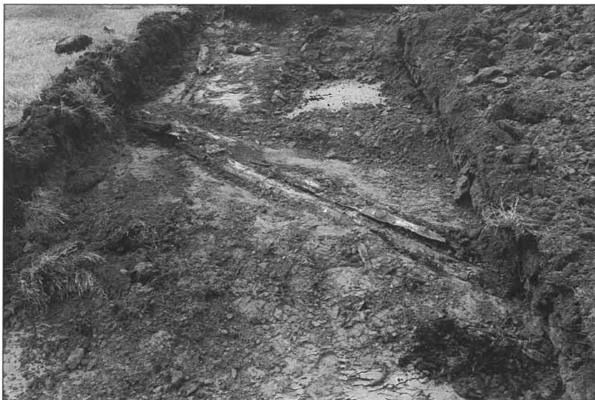
Figur 8. Dreneringsgrøft av tre.
