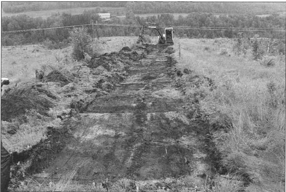
Figur 7. Sjakt like nord for fabrikkanlegget.
